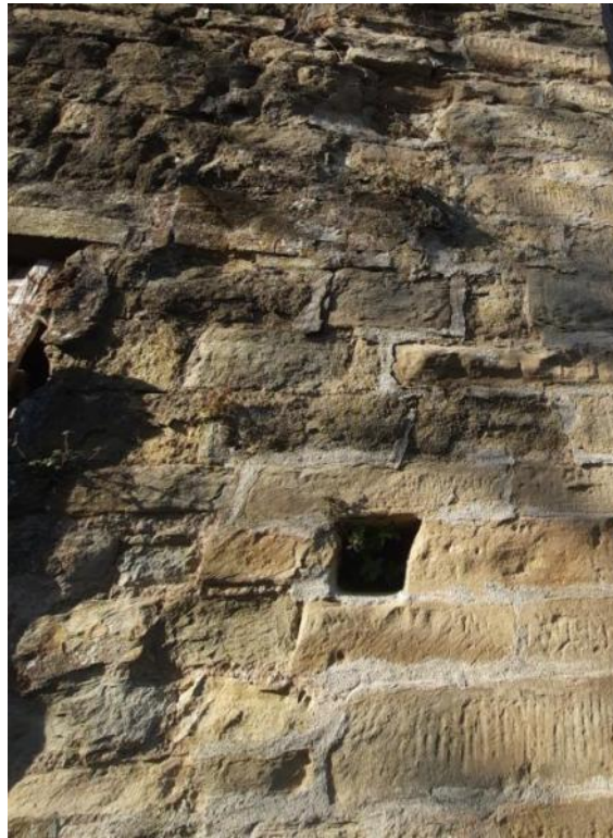
Fig. 7 – Particolare della muratura in cui si riscontra l'eterogeneità della tessitura muraria in cui sono presenti elementi di più recente inserimento rispetto a quelli originari del rudere.
