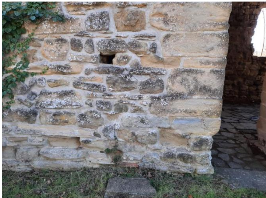
Fig. 5 – Particolare della muratura del prospetto nord del mastio in cui sono individuabili tracce di stilature incongrue di malta cementizia impiegata negli interventi precedenti di recupero che hanno interessato l'intero bene.
