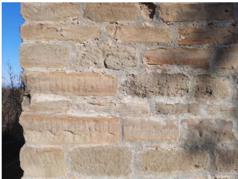
Fig. 6 – Particolare della muratura in cui si riscontra l'eterogeneità della tessitura muraria in cui sono presenti elementi di più recente inserimento rispetto a quelli originari del rudere.
