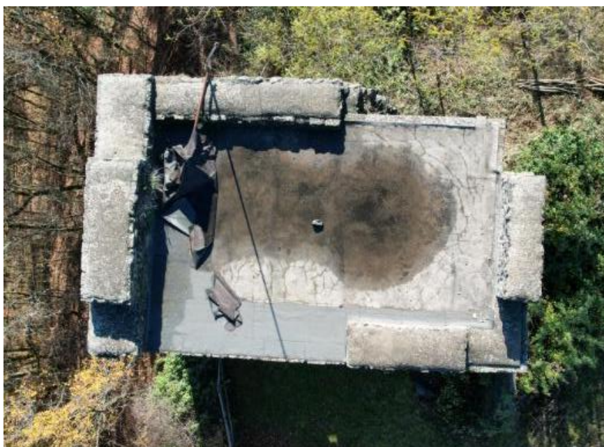
Fig.1 – Vista dall'alto della copertura dell'edificio. Sono visibile importanti mancanze della guaina protettiva che ha comportato l'esposizione del solaio sottostante di recente costruzione compromettendone la sua conservazione.
