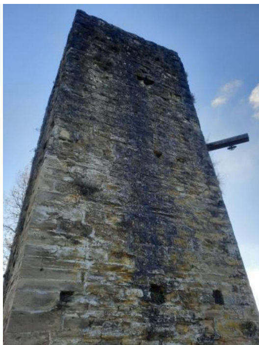
Fig. 3 – Particolare della torre interessata dalla pluralità di fenomeni di attacchi biologici di differenti specie di biodeteriogeni.
