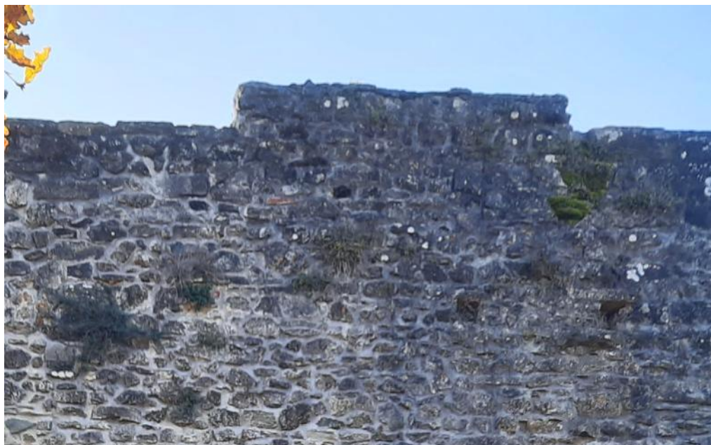
Fig. 2 – Particolare della diffusione sulle porzioni sommitali del rudere delle forme di attacco biologico presente. Si individuano specie arbustive a carattere infestante e la massiccia presenza di licheni e muschi.
