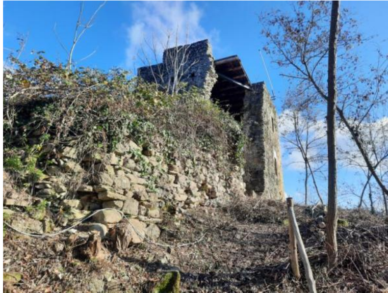
Fig. 4 – Particolare dell'area intorno al mastio, riguardante il prospetto Sud, di alcuni tratti di muratura, invasa dalla vegetazione, che presenta locali crolli e parti instabili.
